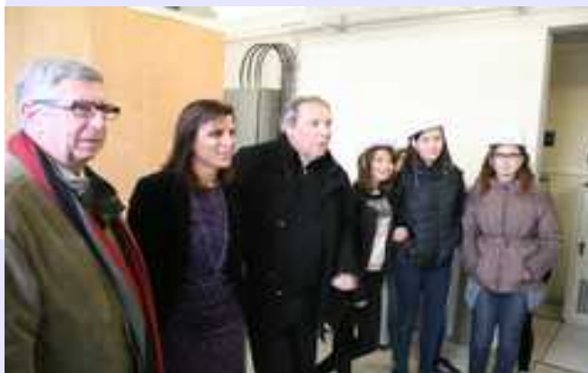
Visite du poste source ERDF à Mauriac
