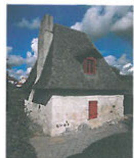
Moulin du Pont du Mamou- Arpajon-sur-Cère
