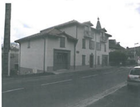
Réhabilitation de logements à Saint-Paul des Landes
