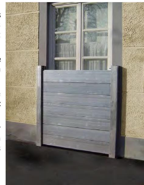
Figure 22 : Exemple de mesure de protection individuelle : le batardeau
