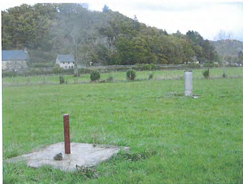
Photo 1 : Têtes du forage F1 et de Pz1
