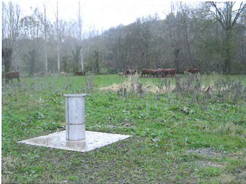
Photo 2 : Tête du forage F2
