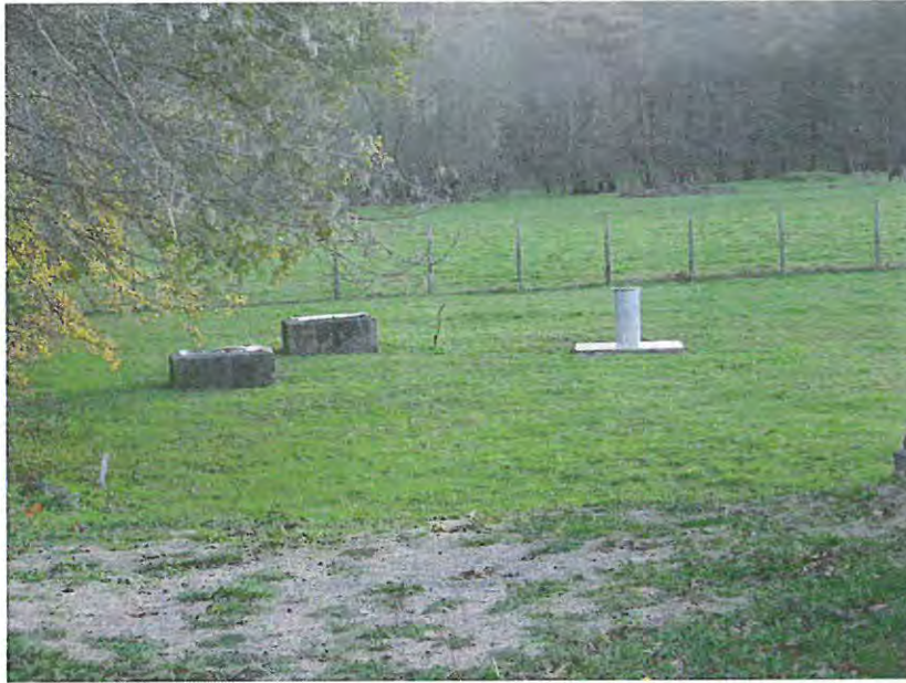
Photo 3 : Tête du forage F3 et regards abritant le forage HS et le forage exploité par la ville de Bort les Orgues
