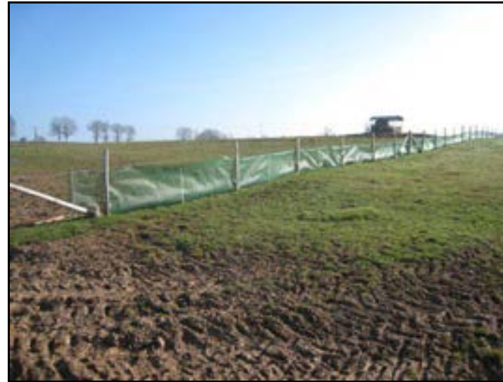
Figure 19 : Clôtures provisoires en phase chantier pour empêcher l'accès des batraciens aux emprises travaux
