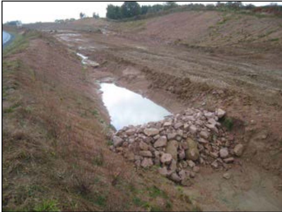
Figure 22 : Mise en place d'un réseau provisoire
