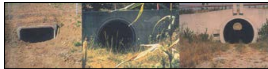
Figure 20 : Aménagement pour passage de petite et moyenne faune
