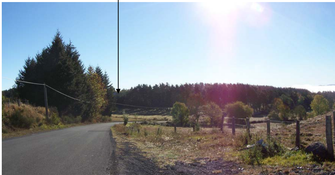
Photographie n° 1 : Perception visuelle dynamique du site pour un observateur circulant sur la RD 10, en direction du bourg de Lavastrie et arrivant aux abords de la carrière de la Devèze. A l'exception d'un très court linéaire de la partie supérieure du front de taille « est », perceptible à la faveur d'une trouée dans la végétation, le site de la carrière ne peut être perçu par un automobiliste ou un promeneur.
