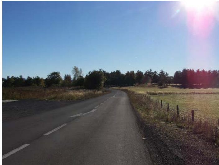
Photographie illustrant les conditions de visibilité offertes aux utilisateurs circulant sur la RD 10 en direction de la carrière de la Devèze
