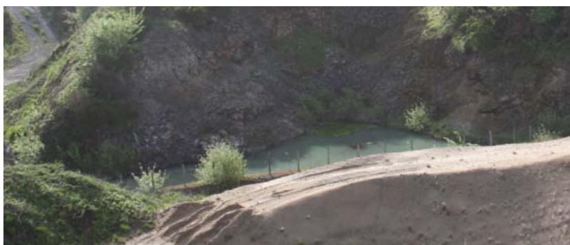
Vue du bassin collectant les eaux →
