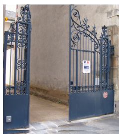
Portail Entrée du STAP
