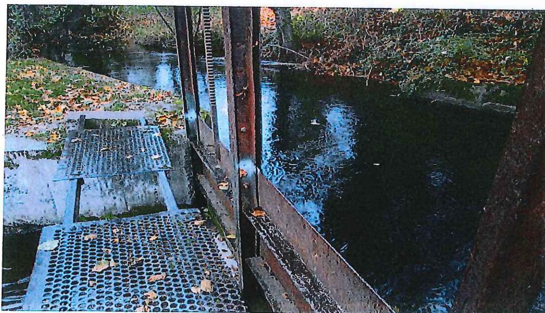
*Dans cette configuration, en l'absence de surverse le débit réservé dans l'Alagnon est de 350l/s (Passe à poissons) + 250l/s (vanne de décharge) soit un total de 600l/s.*
