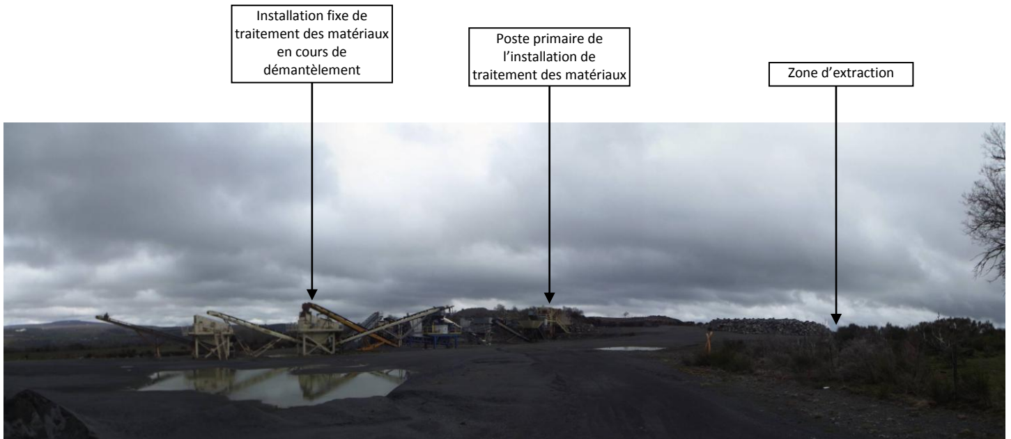
Prise de vue illustrant l'ensemble des équipements de traitement disposés dans l'emprise de la plate-forme technique « Nord »
