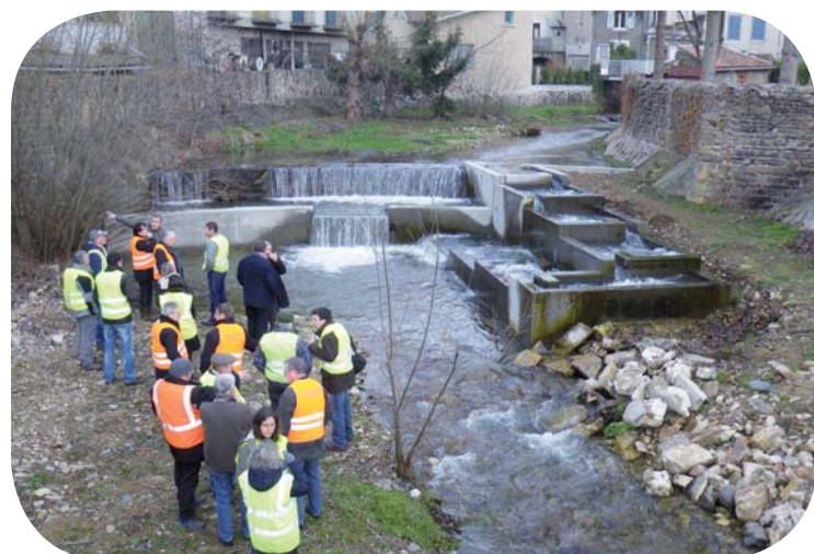
Passé à poissons sur l'Alagnonnette, réception des travaux en 2014
