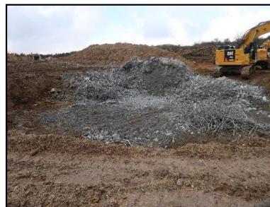
Démolition d'une fondation Source : Artifex 2018
