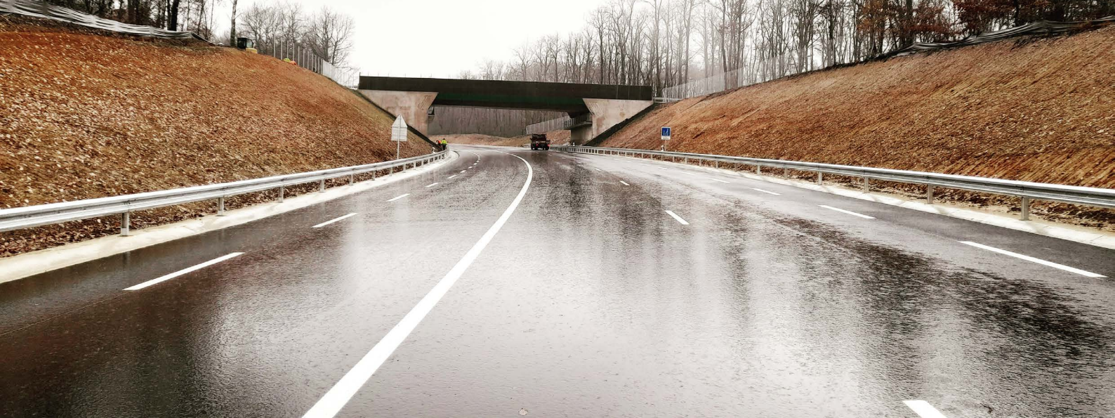
Passage supérieur route d'Ytrac
