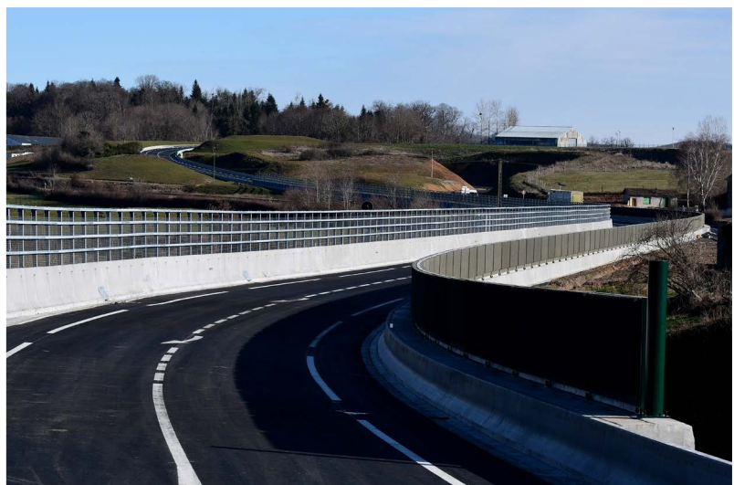
Protection des voies SNCF et mur anti-bruit
