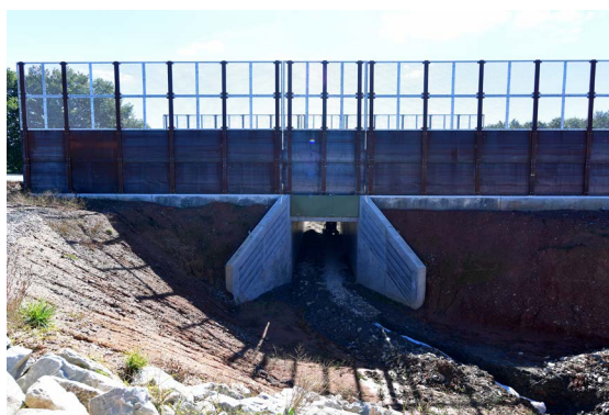
Passage piétons/cyclistes au Pas du Rieu
