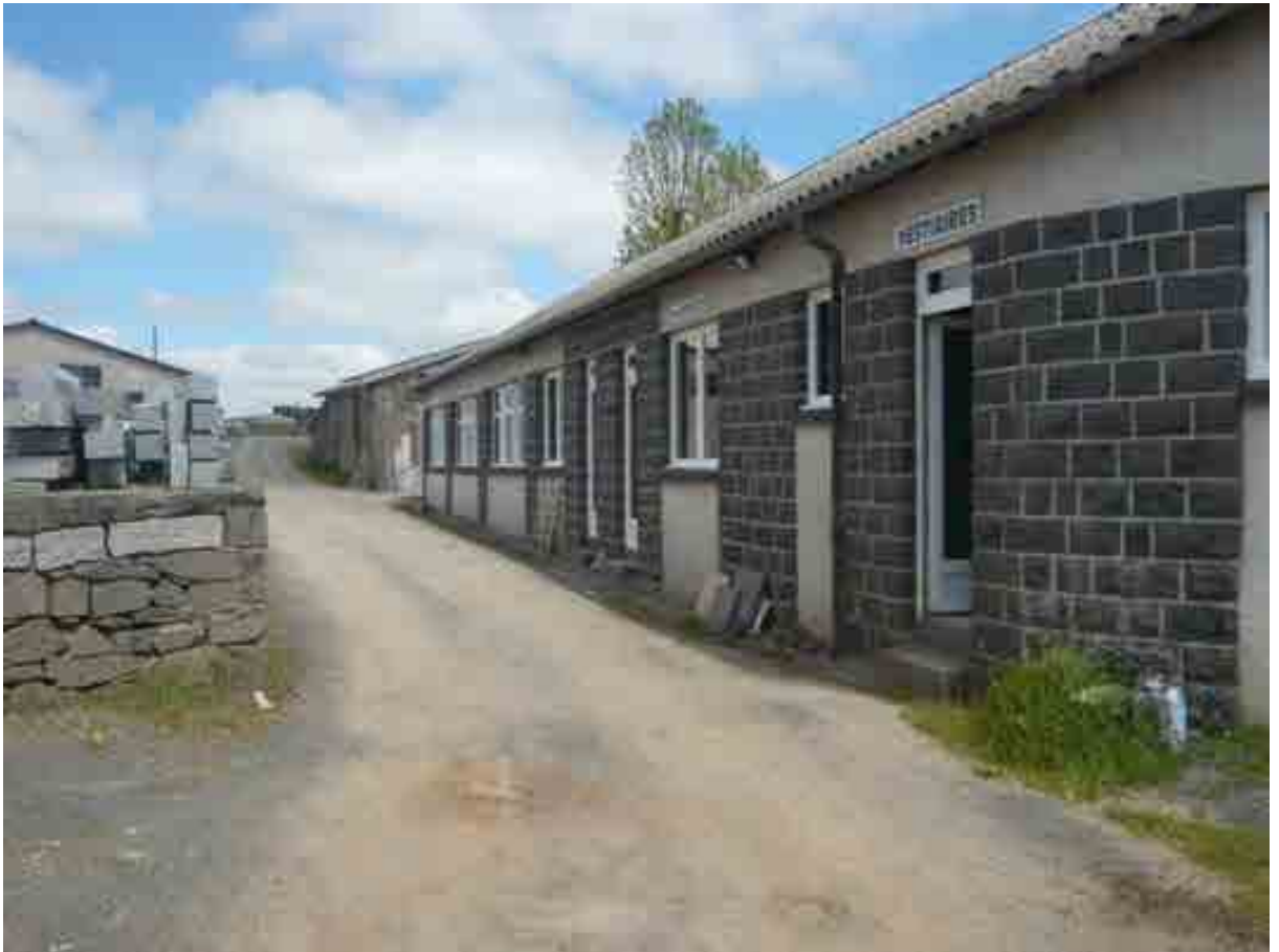
VOIE D'ACCES AU SITE
