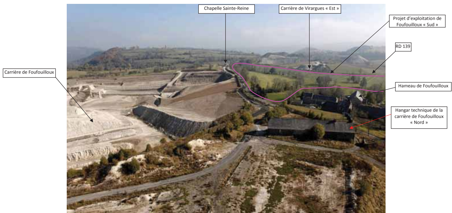
Vue rapprochée du hameau de Foufouilloux et de l'emprise du futur projet d'exploitation depuis le secteur du hangar technique de la carrière de Foufouilloux
