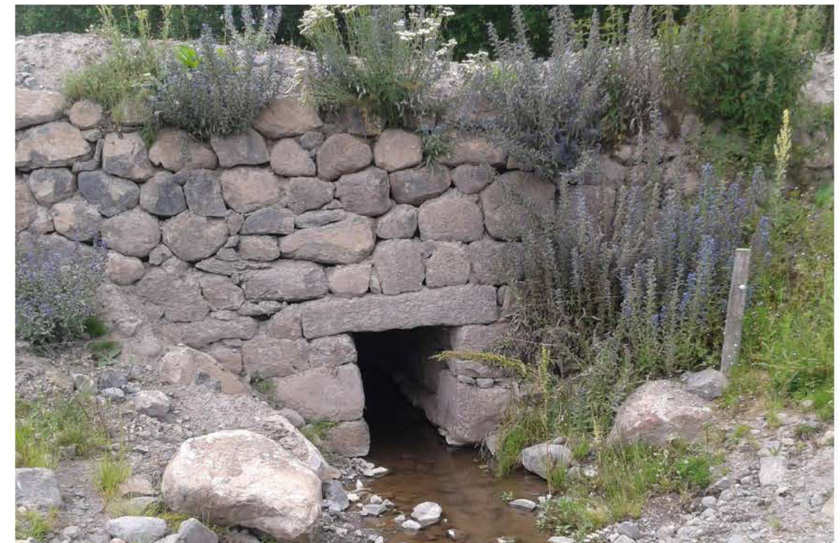
Photographie n°2 illustrant l'ouvrage permettant le franchissement de la piste de la carrière
