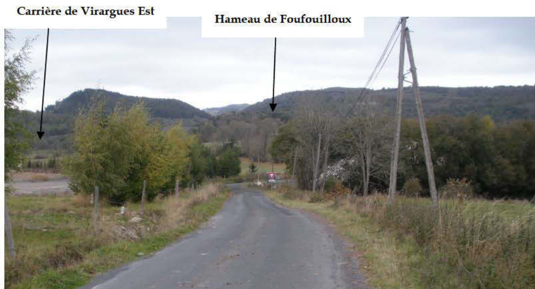
Photographie illustrant la position de la ligne électrique présente en bordure de la route départementale 139.
