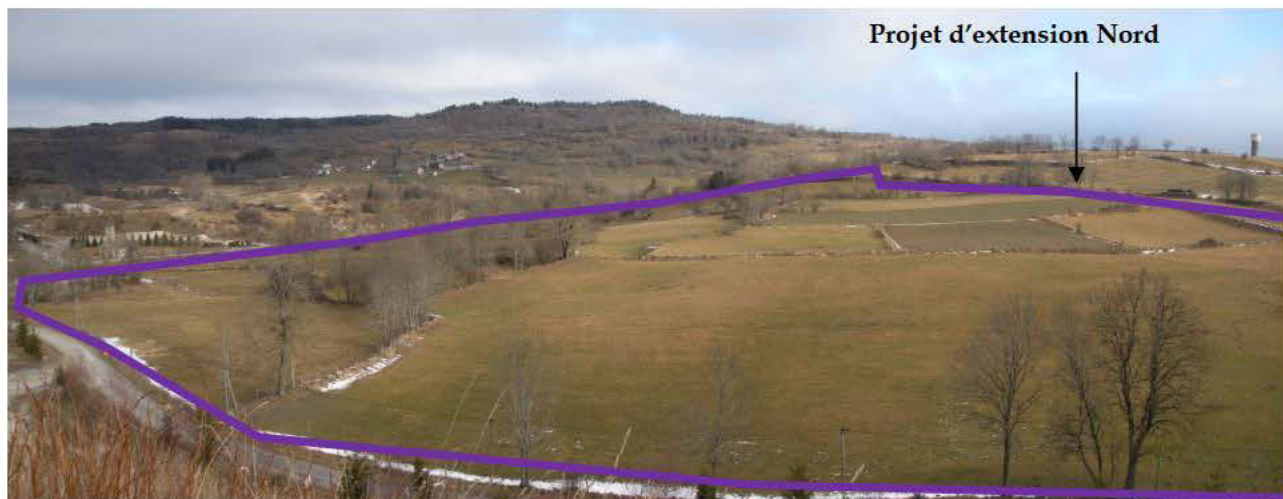
Prise de vue illustrant l'occupation du sol au droit des terrains intégrés au projet d'extension Nord Photographie réalisée depuis le haut du stock de terre de découverte localisé au droit de la limite cadastrale Est de l'actuelle carrière
