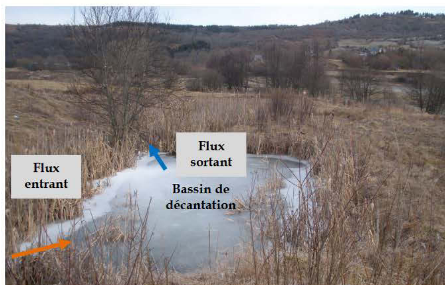
Photographie illustrant le bassin de décantation implanté sur la carrière de Virargues « Sud »
