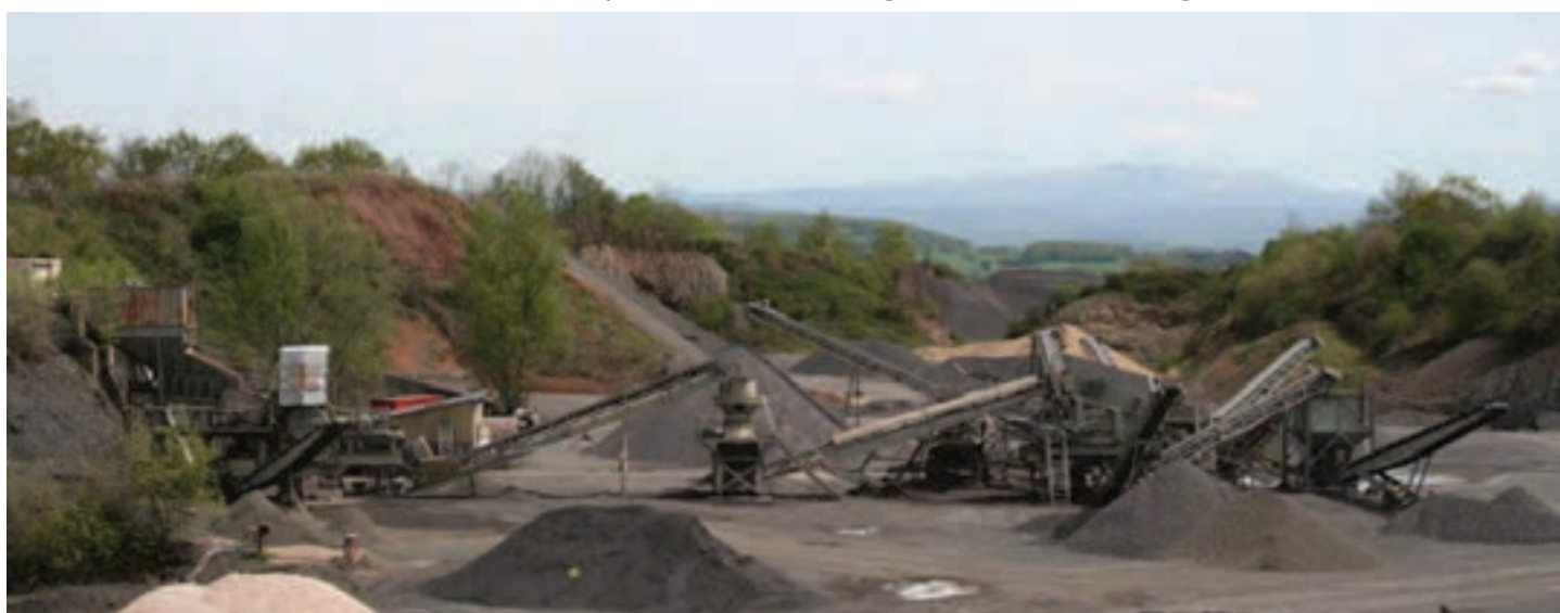
Vue générale des installations de traitement
