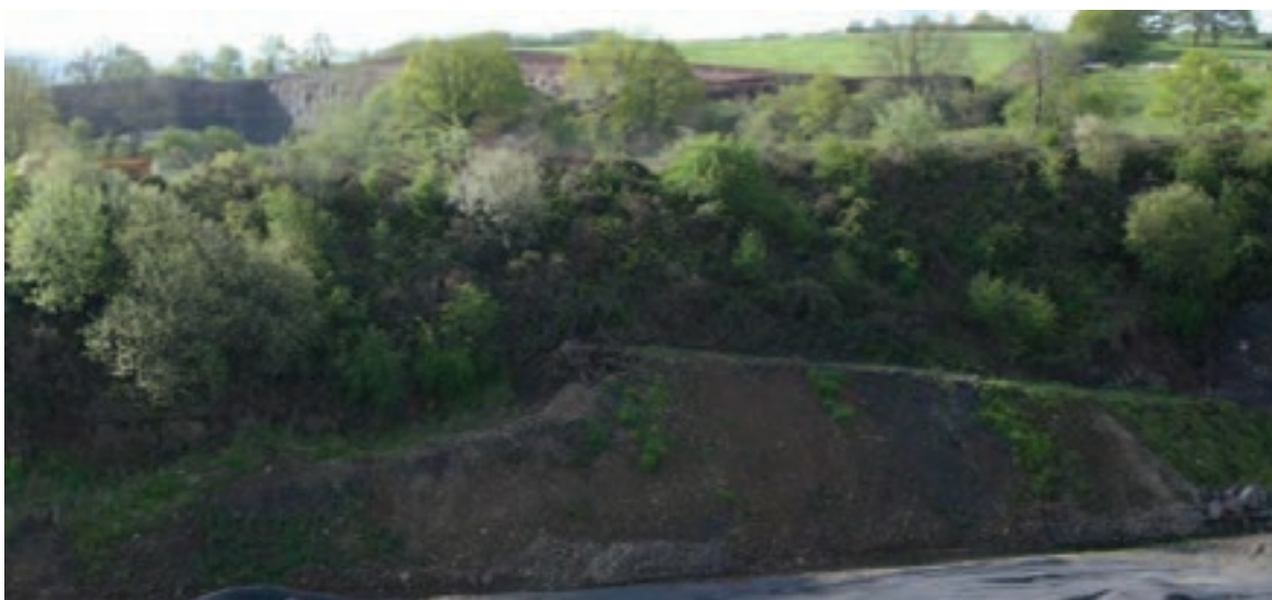
Végétalisation naturelle des secteurs talutés
