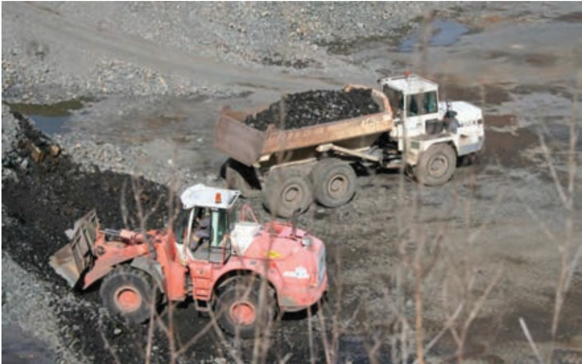
Reprise des matériaux abattus et extension du carreau cote 640 NGF
