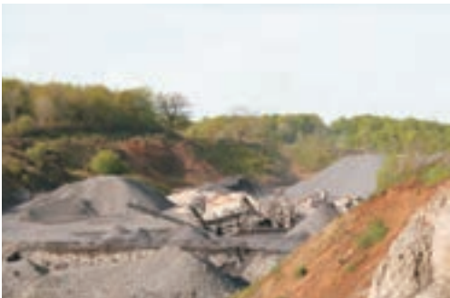
Les installations et les stocks dans la partie centrale du site
