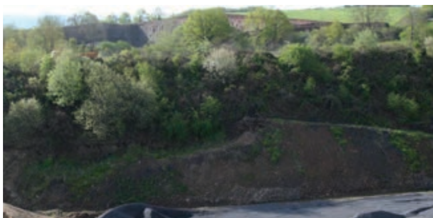
Exemples de fronts réaménagés avec une pente de 3H/2V (ou légèrement supérieure) et présentant une bonne stabilité
