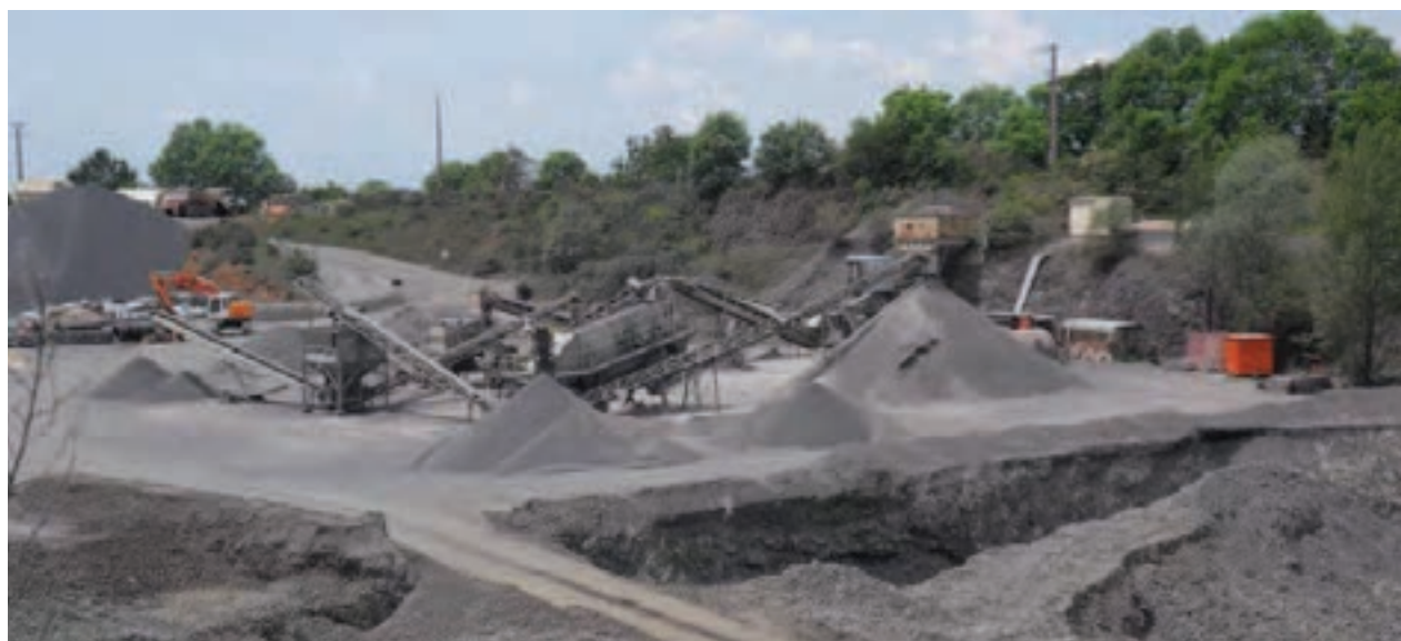
Vue des installations de traitement
