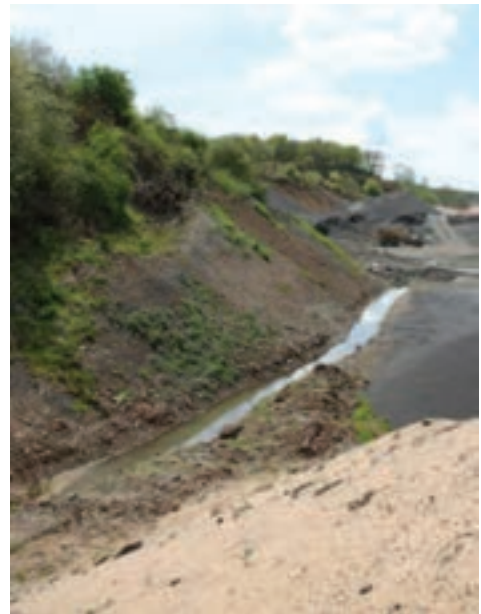
Fossé collectant les eaux sur le carreau, au pied des fronts Est
