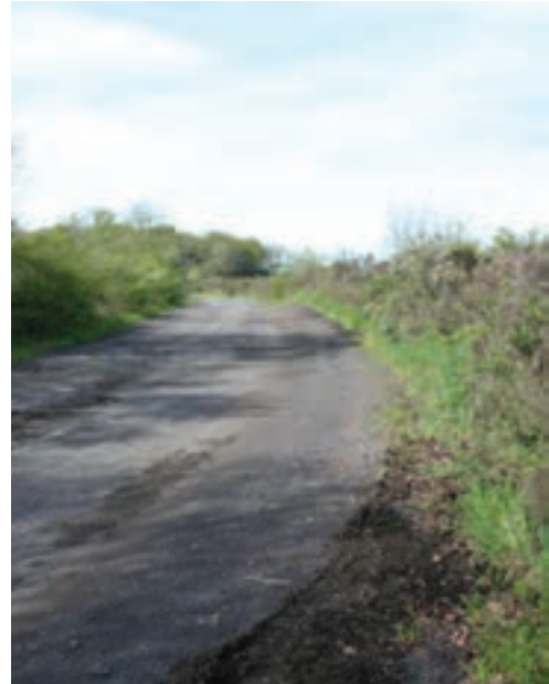
Piste desservant la carrière voisine, bordée de talus ou merlons empêchant le ruissellement des eaux vers les terrains riverains.
