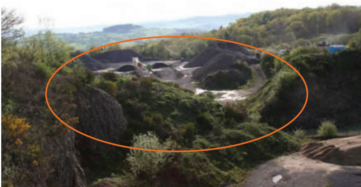
Eperons à enlever entre le site étudié et la carrière voisine
