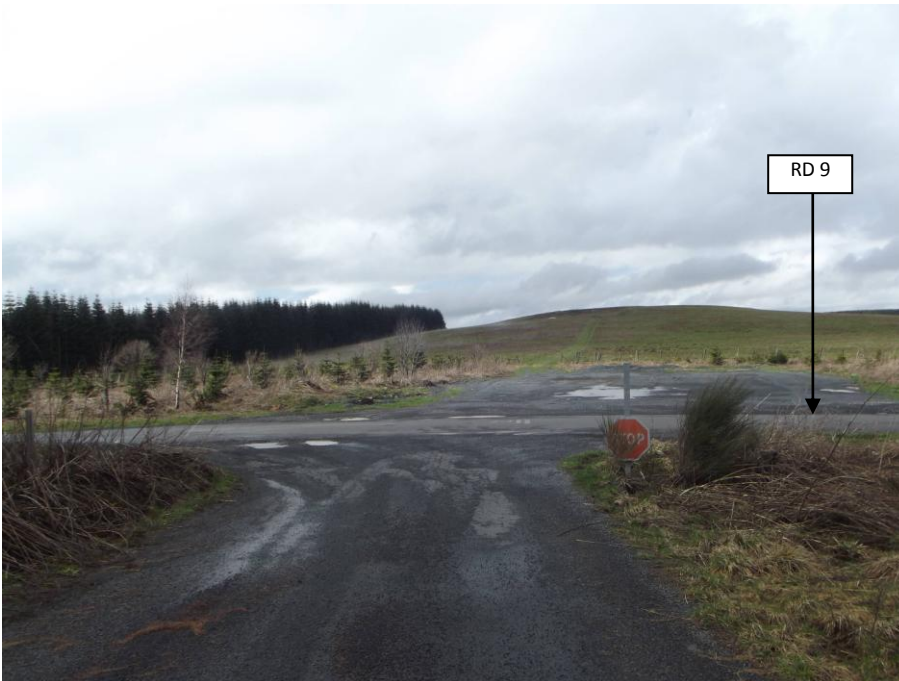
Photographie n° 3 : Débouché du chemin d'accès privé sur la RD 9.
