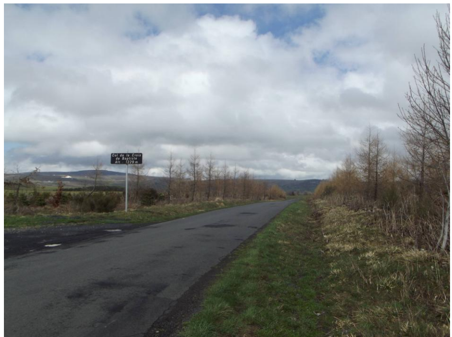
Photographie n° 4 : Configuration de la RD 9 immédiatement au Nord du point d'accès à la carrière. Une excellente visibilité est offerte aux véhicules qui s'insèrent sur cet axe routier depuis le chemin d'accès.
